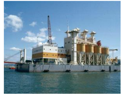
モルタルプラント船
