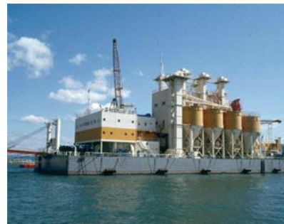
モルタルプラント船
