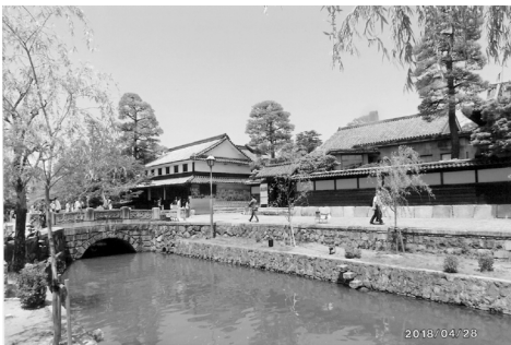
大原本邸の外観 (奥の白い建物)
